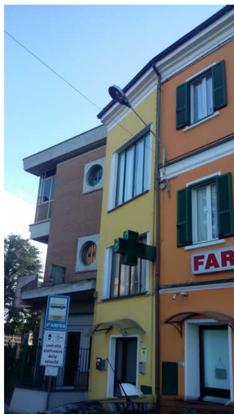
CORPO ILLUMINANTE DI TIPO STRADALE APERTO POSTO SU SOSTEGNO DI TIPO SBRACCIO
