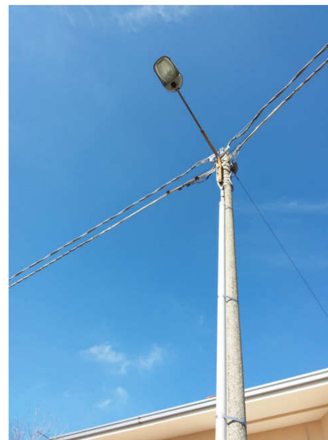
PALO STRADALE CON CORPO ILLUMINANTE DI TIPO STRADALE VETRO PIANO POSTO SU SOSTEGNO DI TIPO SBRACCIO
