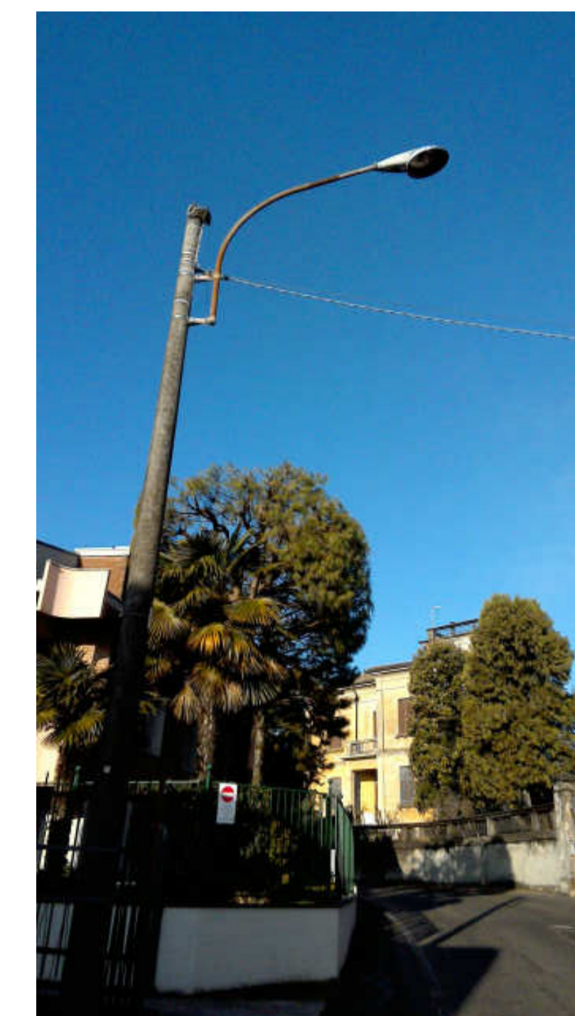
PALO STRADALE CON CORPO ILLUMINANTE DI TIPO STRADALE APERTO POSTO SU SOSTEGNO DI TIPO SBRACCIO
