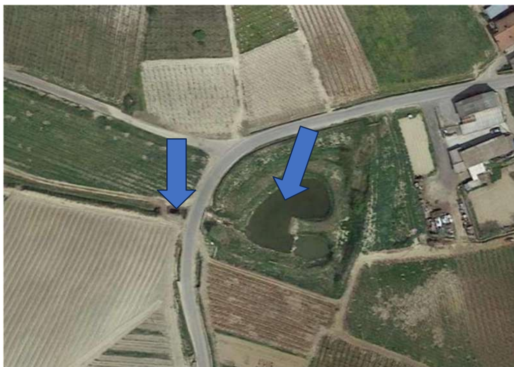
Figura 21: Manufatto di attraversamento stradale e bacino di laminazione naturale realizzato nel 2012.
