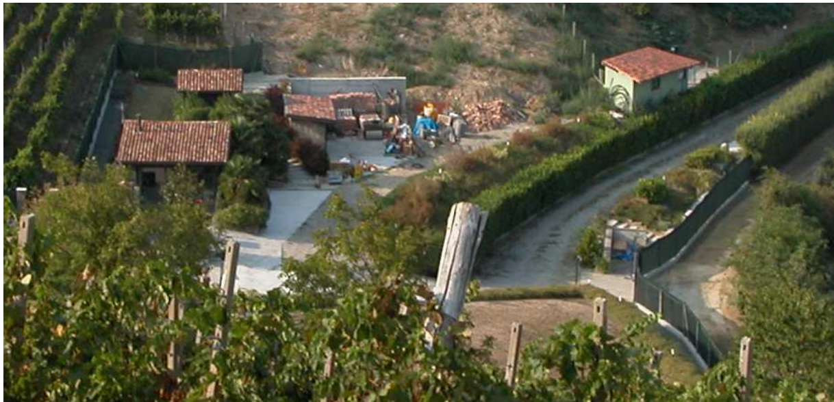
Foto 6: Complesso di edifici ubicato al centro del corpo di frana.
