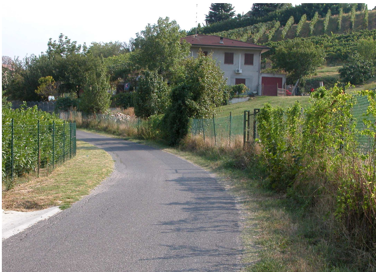
Foto 2: La sede stradale, trasversale al corpo di frana, priva di lesioni.
